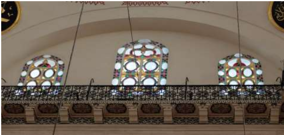
F.6 Süleymaniye Camii, Mihrap cephesinde revzenler (Yıldır, 2017)
